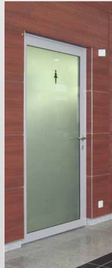
Sichtschutz durch Mattfolie innerhalb des Glases.
