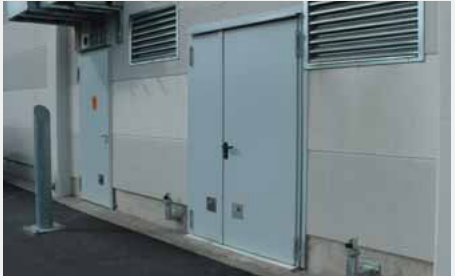
dw 75-1/S und dw 105-2/S zur Schalldämmung von Klimaanlagen
