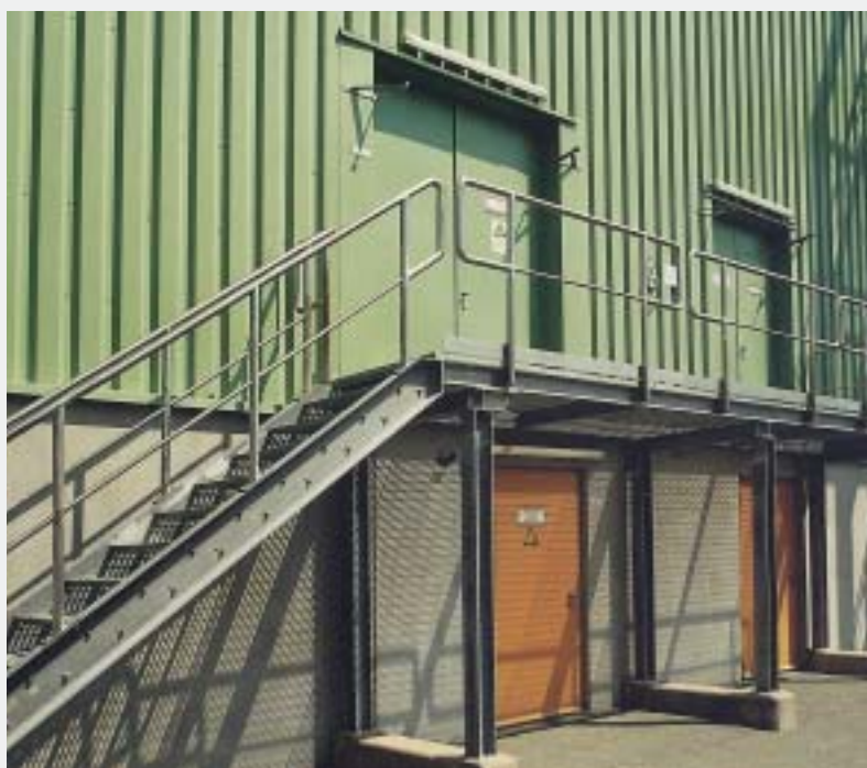
Einbruchhemmende Feuerschutz-Stahltür, T90-2 „Teckentrup SV“, WK 3.
